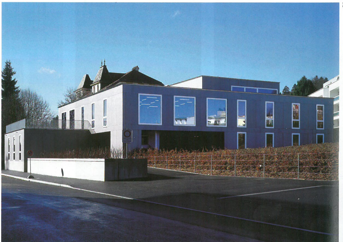
1 Nüchterne, sparsame Hüllen-Architektur: «Graue» Einkleidung (Eternit) und fassadenbündig in Metall gesetztes Glas sind hier tonangebend.
